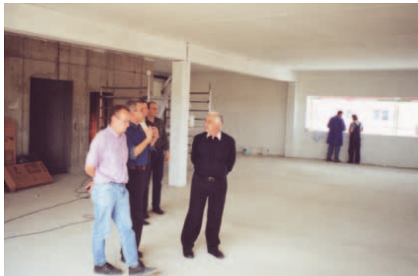
Caritasdirektor Johannes Schmidt (Direktor von 1986 bis 2011) informiert sich vor Ort über den Baufortschritt.
